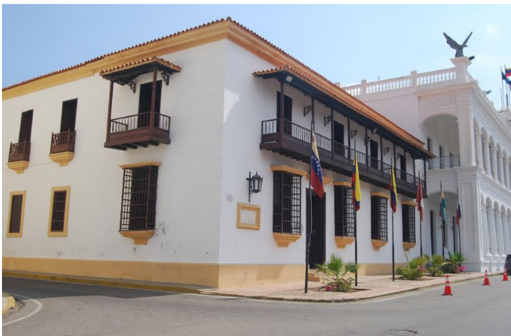
Fachada principal de la casa de la Capitulación. Fotografía de Evelyn Canaán.
