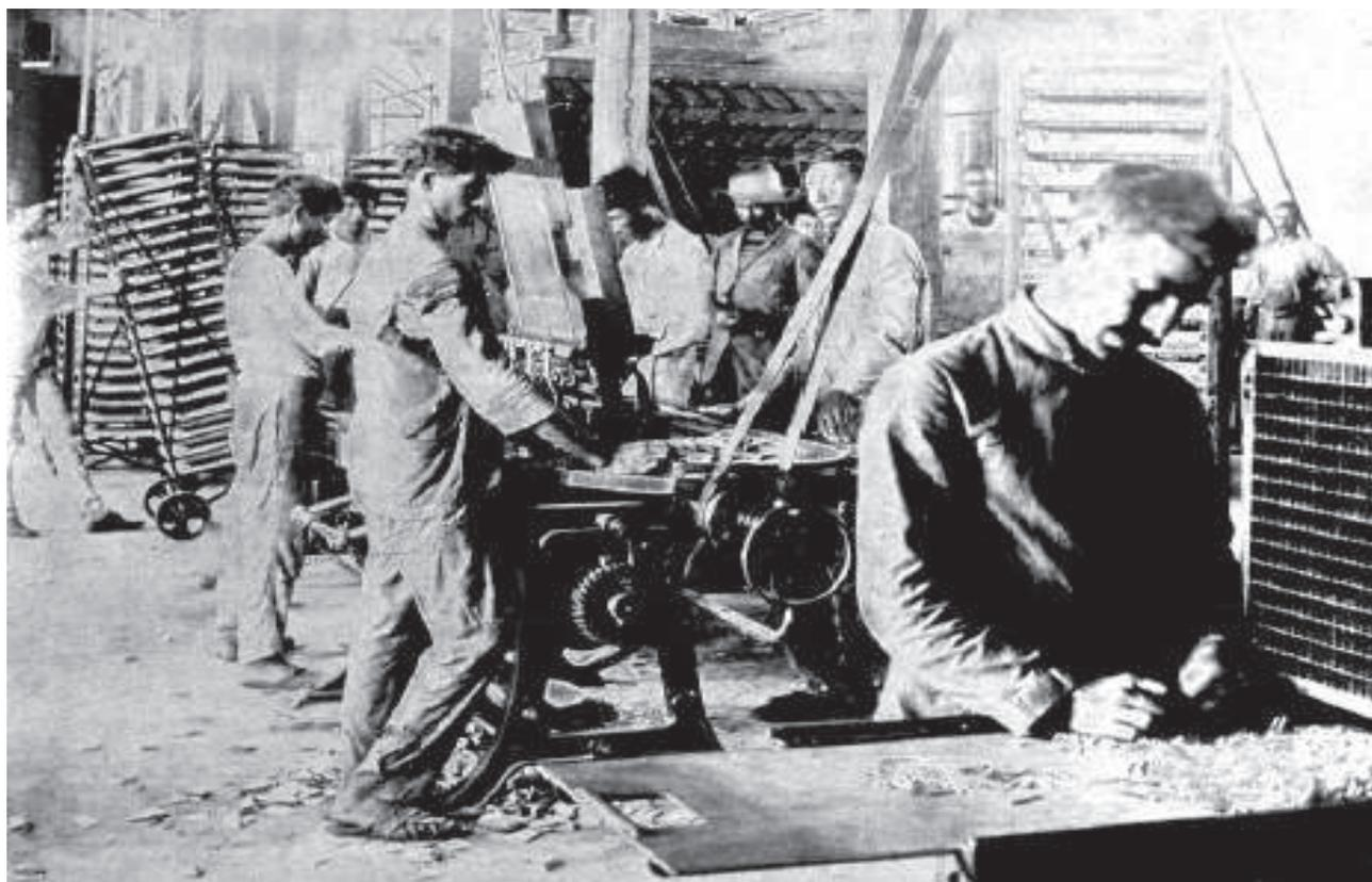
FÁBRICA DE FÓSFOROS – MARACAIBO – MÁQUINA DE VACIAR TELERAS – MÁQUINA DE LLENAR CAJITAS – SECADORES
