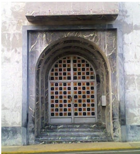
PUERTA DE ACCESO DEL PALACIO ARZOBISPAL.
